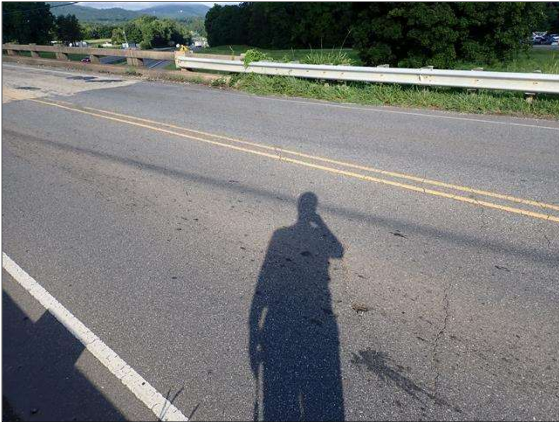
end bent 2 asphalt
